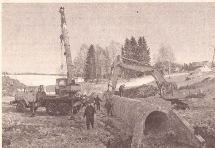
Дорожным строителям предстоит построить много водопропускных сооружений. Одно из них - в д.Александровка.
