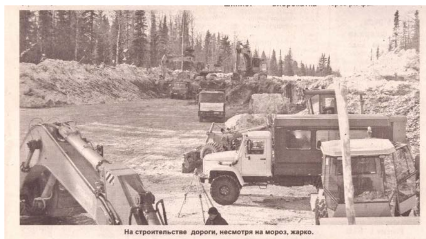
На строительстве дороги, несмотря на мороз, жарко.
