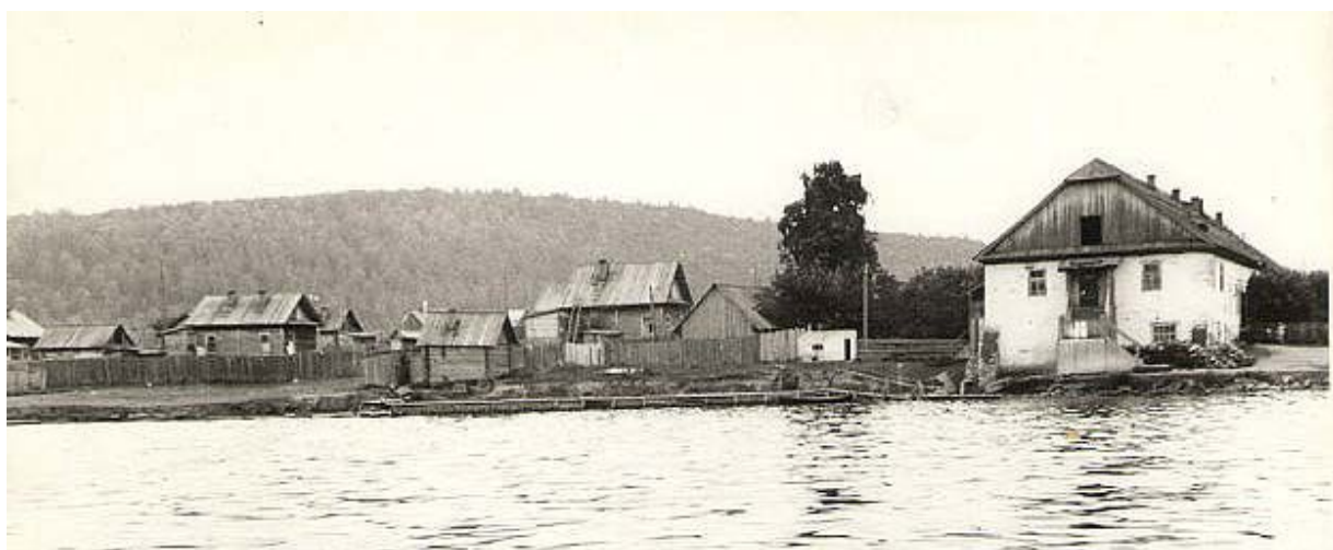
Альбом Сергея Козлова. 20 век. Северная сторона бывшего манаевского склада, в пору, когда в этом конце здания размещалась контора отдела рабочего снабжения Магинского леспромхоза.
